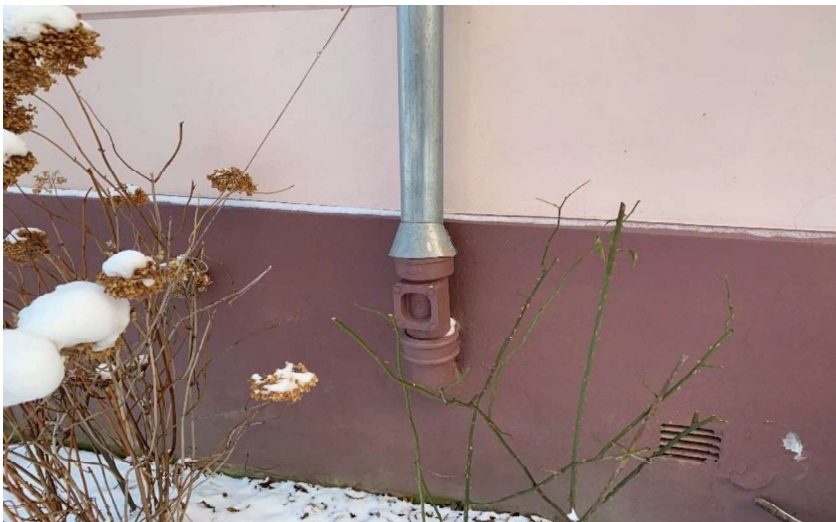
Foto 16: Taknedløp med tilgang via stakeluke
