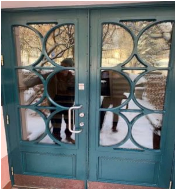
Foto 5: ytterdør oppgang B
