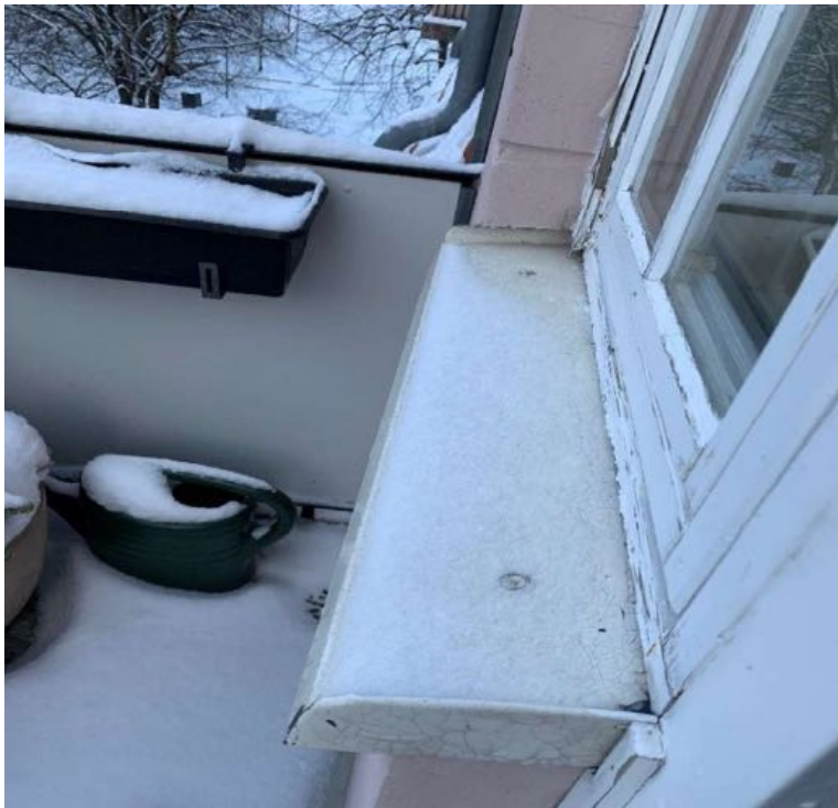
Foto 4: vindu fra 1986 i gavlvegg mot syd, vannbrettbeslag plastisolbelagt stål
