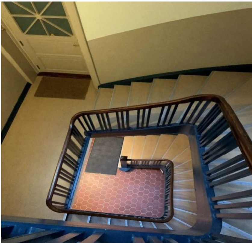
Foto 20: hoved trappehus oppgang A
