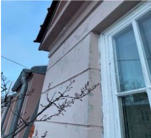
Foto 8: malings slitasje sydgavl (foto fra H0401)
