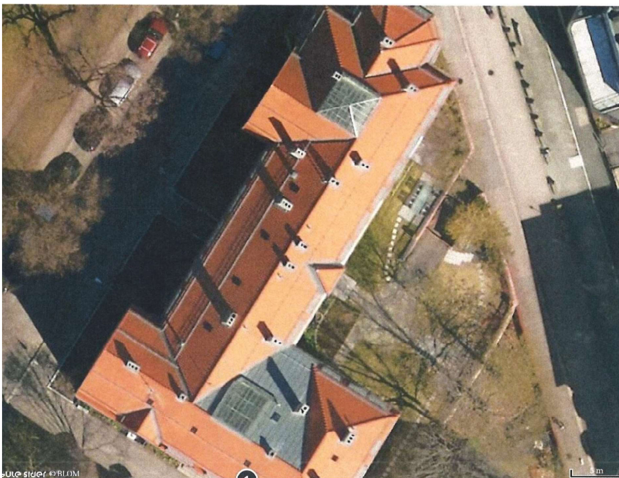
Foto 11: flyfoto av taket i Geitmyrsveien 9
