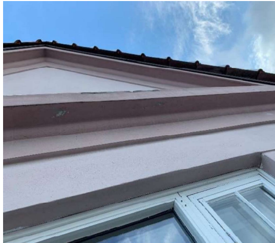
Foto 9: noen skader i puss over trekning/arkitrav på syd-gavl
