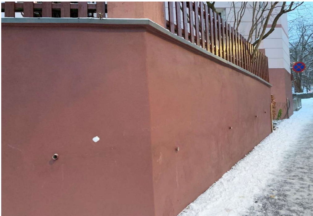
Foto 1: Støttemur mot Bergsliens gate
